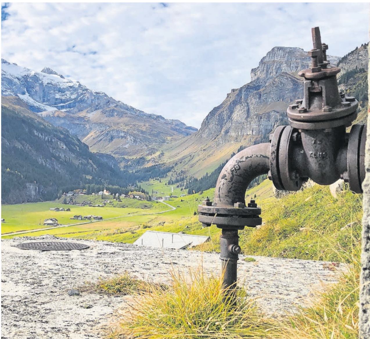
Die Wasserversorgung auf dem Urnerboden hat eine bewegte Geschichte hinter sich. Das alte Wasserreservoir im Mättenwang stammt vermutlich noch aus den Vierzigerjahren. FOTO: HEIRI ARNOLD
