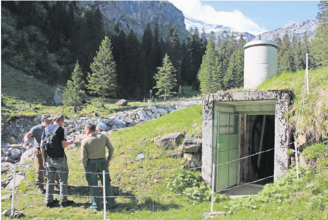
Das Wasserreservoir im Gebiet Wildenboden wird von mehreren Quellen aus dem Claridengebiet gespeist und fasst insgesamt 300 Kubikmeter Wasser.
